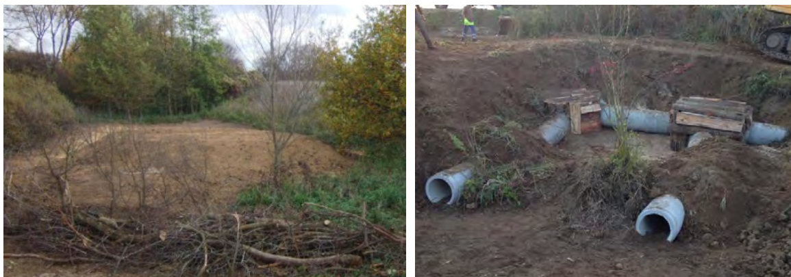
Figure 38 : Terrier artificiel construit à Housсен (Haut-Rhin) en 2015 au pied d'une digue. ©Laetitia Duhil
