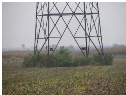
Figure 62 : Végétation spontanée sous un pylône électrique.
