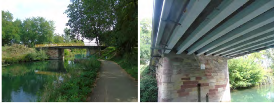
Figure 14 : Les ponts peuvent potentiellement être des sites propices à l'installation de nichoirs ou gîtes à chauves-souris.
