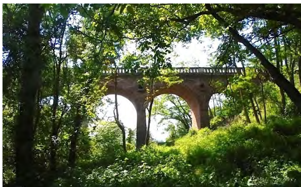
Figure 32 : Pont en grès d'une voie de chemin de fer traversant un vallon.
