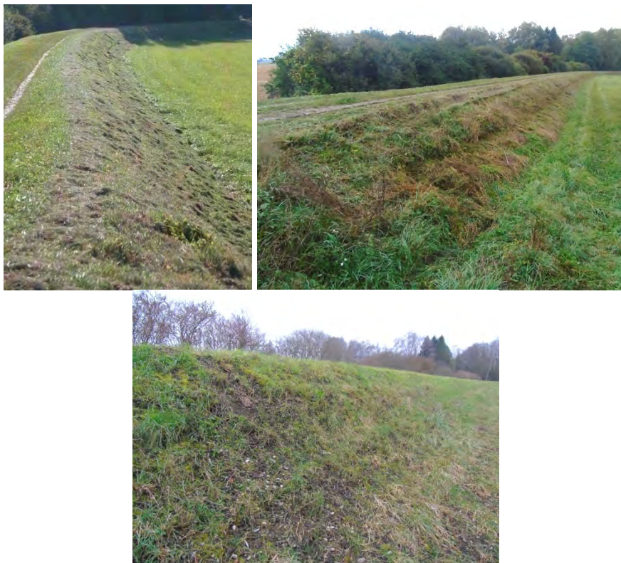
Figure 22 : Digue de l'Ill à Muttersholtz avec à gauche, son aspect après un broyage sans exportation en 2018 ; à droite, aspect de la même digue après une fauche à la barre de coupe (avant exportation), puis son aspect après exportation en 2020, en bas.
