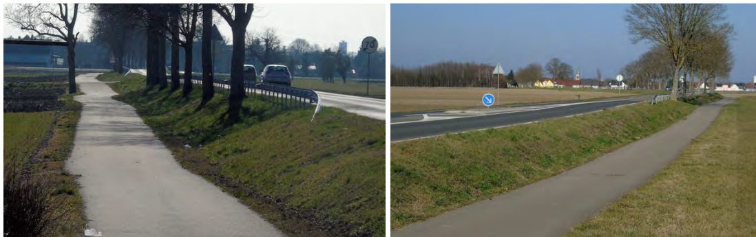
Figure 67 : Piste cyclable longeant une route en Alsace centrale.
