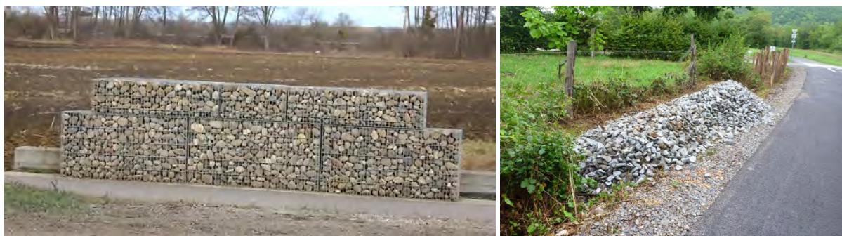
Figure 69 : A gauche un gabion rempli de galet servant de parapet le long d'une piste cyclable ; à gauche un tas de pierres spécialement installé pour les lézards le long de la voie verte de Rosheim. ©V. Clément-Demange
