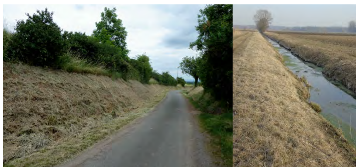
Figure 87 : Aspect d'un talus et des berges d'un fossé après broyage.
