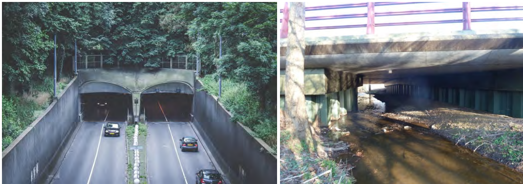
Figure 44 : A gauche un exemple d'écopont pour la faune (@Pixabay) ; A droite un exemple de passage sous une autoroute, en bordure d'un ruisseau, avec une berge en remblai très utilisée par la faune.
