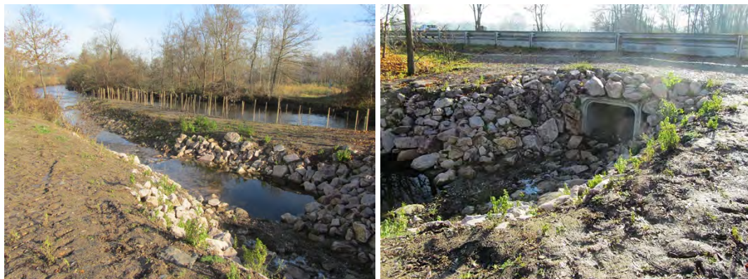
Figure 45 : Passé à Castor, avec un chenal en direction d'un passage souterrain permettant aux castors de passer sous la route dans le sens aval-amont, le courant dans la rivière étant trop fort pour remonter à la nage (Sélestat).
