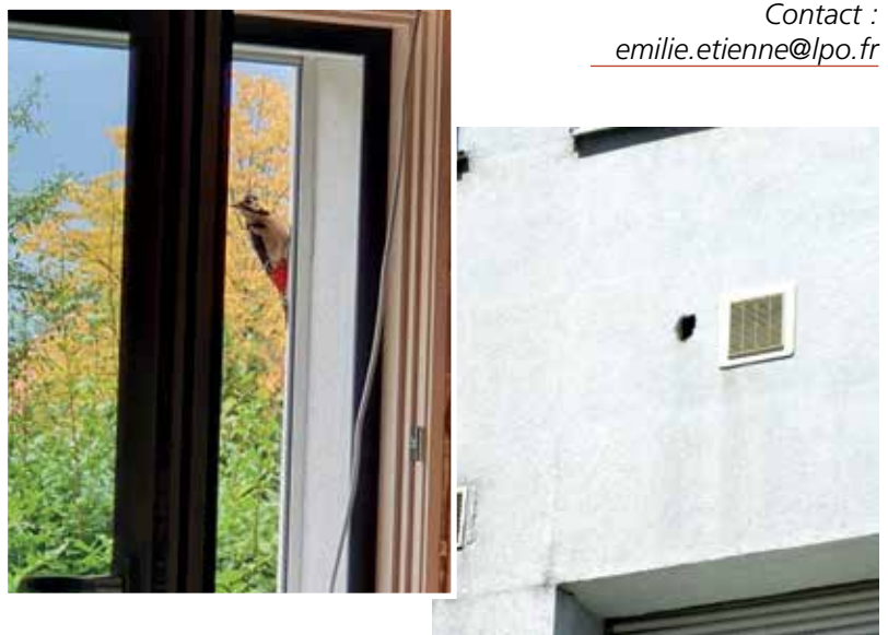
Les pics verts et les pics épeiches sont les deux espèces les plus friandes de nos isolations (photo M.Hogard et pôle Médiation Faune Sauvage)
