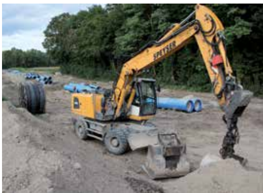
Pose de la conduite du champ captant (photo Jean-Marc Bronner)
