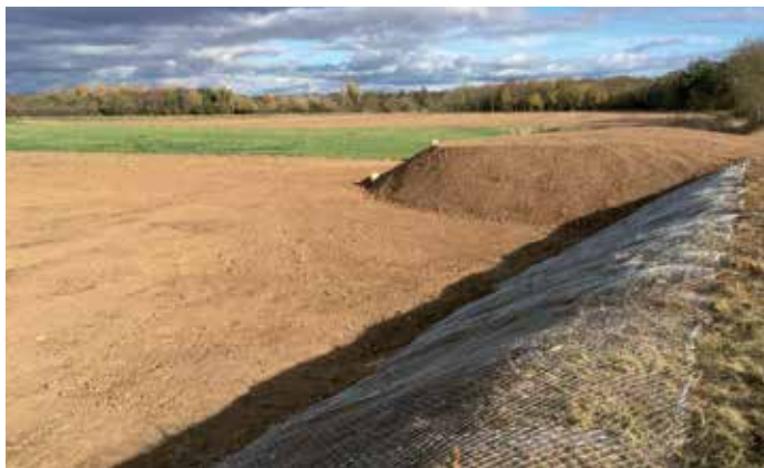
Vue du remblai terminé, avec pose du grillage sur le talus (photo Laetitia Duhil)
