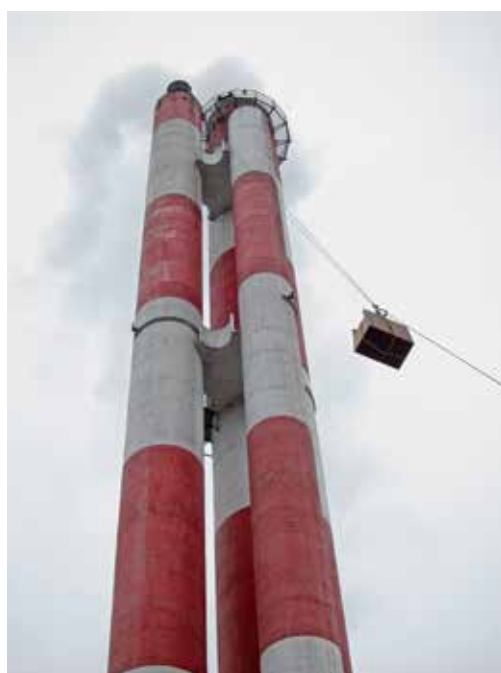
Installation du nichoir au haut des cheminées du quartier de HautePierre (photo Olivier Steck)
