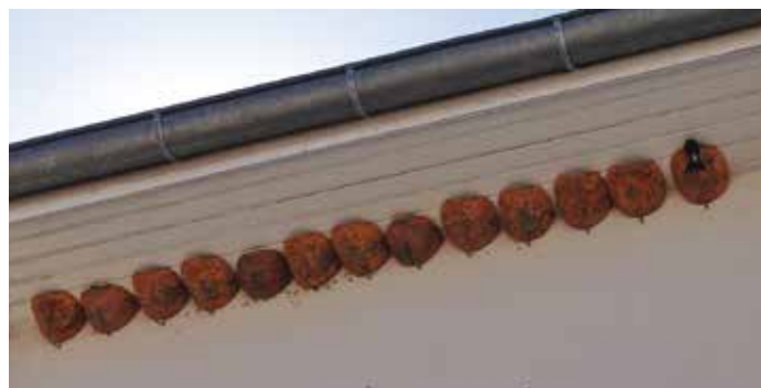
Installation des nids à hirondelles à Bollwiller (photo Philippe Defranoux)
