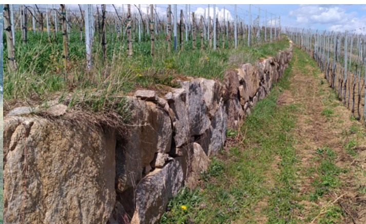
Muret en pierres sèches dans un vignoble. © Arthur Keller
