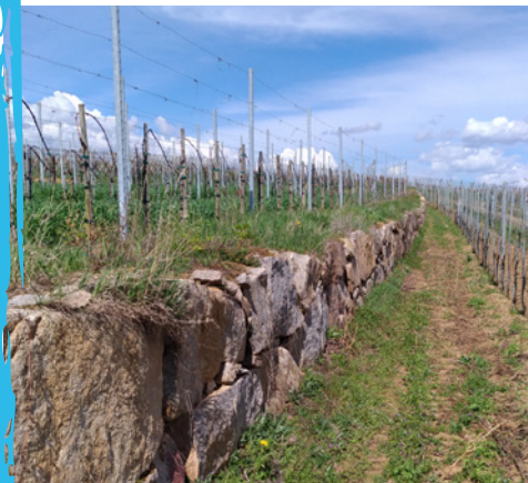
Muret en pierres sèches. © Arthur Keller
