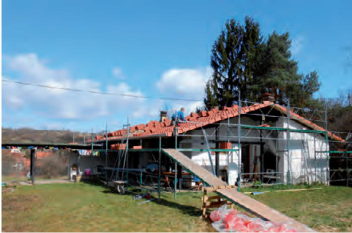
Réfection de la toiture du bâtiment administratif (© Suzel HURSTEL)
